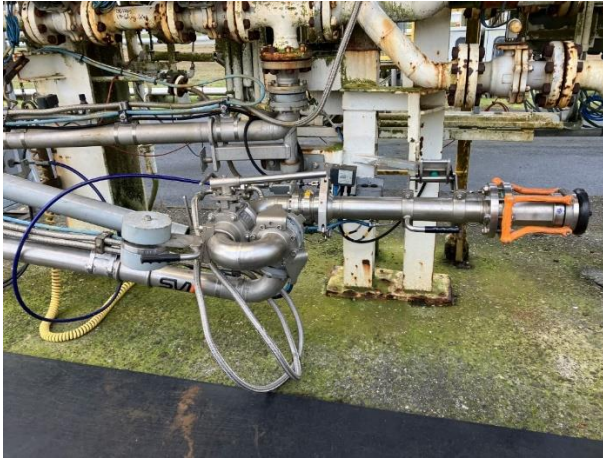
Abbildung 23: Flüssiggas-Entladearm (Fa. SVT)
