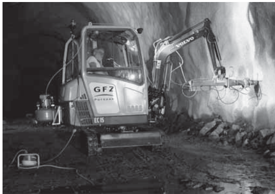
Abbildung 1: Einsatz eines pneumatischen Impuls-Hammers als seismische Quelle im Tunnelbau, die Positionierung und Anpressung wird mit Hilfe eines Kleinbaggers realisiert.
