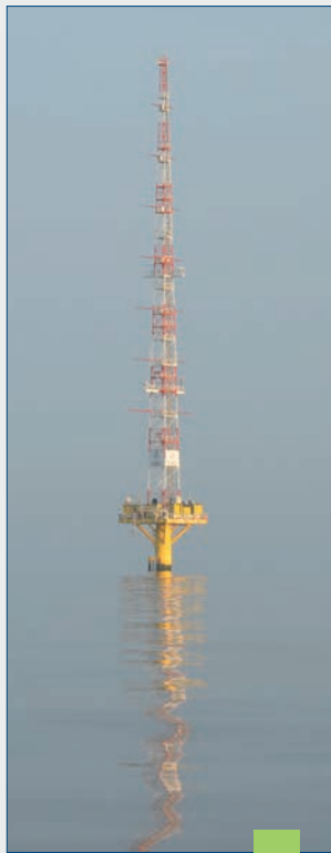
Auf der Forschungsplattform FINO 2 ist das IOW für die Entwicklung und Installation der hydrographischen Messsysteme verantwortlich. / At the research platform FINO 2 IOW is responsible for the development and installation of the hydrographic measurement systems. (Foto / Source: IOW)
