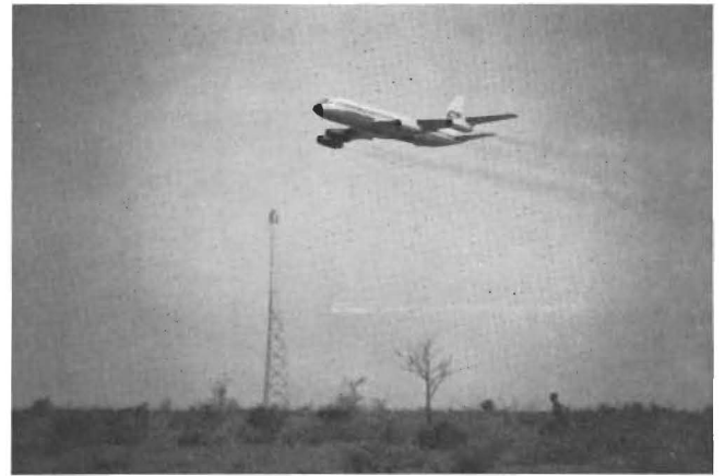
Abb. 8.10 Vergleich von Flugzeuginstrumenten mit denen auf einem 50 m hohen Mast (tower fly-by) in der Savanne 50 km östlich von Dakar. Der hier vorbeifliegende NASA Jet (CV-990) mußte an diesem Tage 18 Mal im Tiefflug in genau 50 m am Turm vorbeifliegen.
