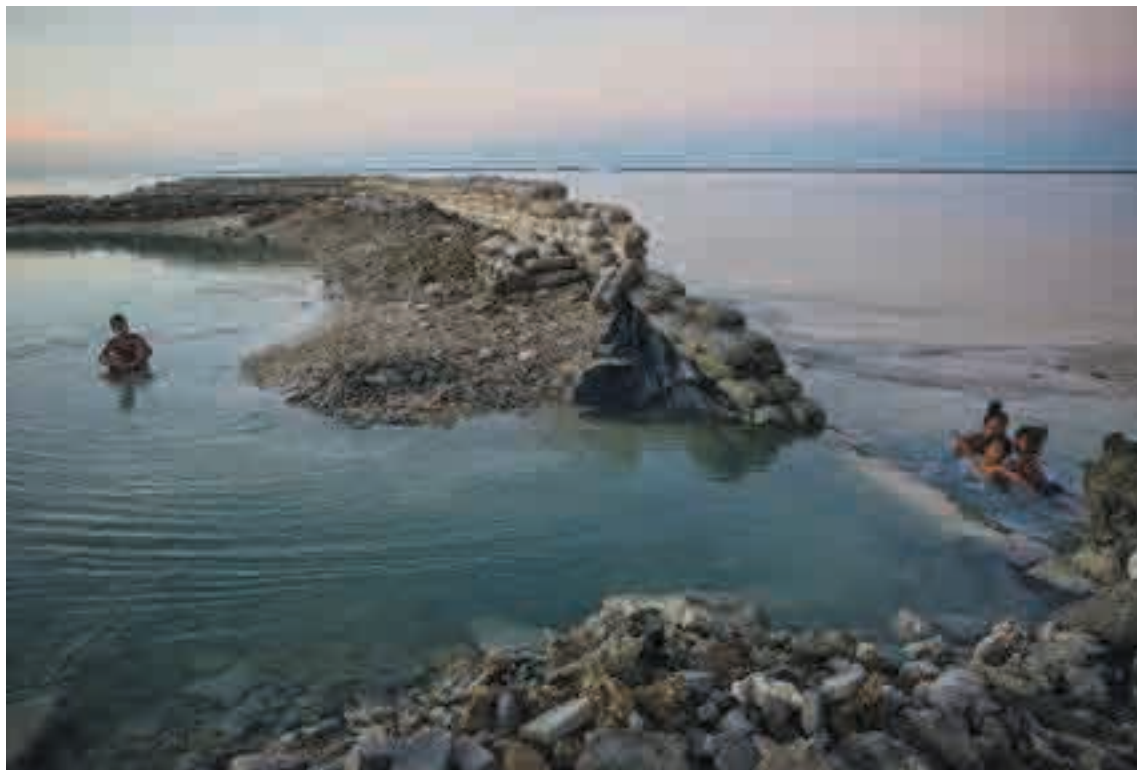
4.14 > Der Inselstaat Kiribati bemüht sich, seine flachen Atolle teils durch massive Mauern vor dem Meer zu schützen. In vielen Fällen aber zerstören Sturmfluten die Bauwerke, wie hier vor der Hauptstadt South Tarawa.
