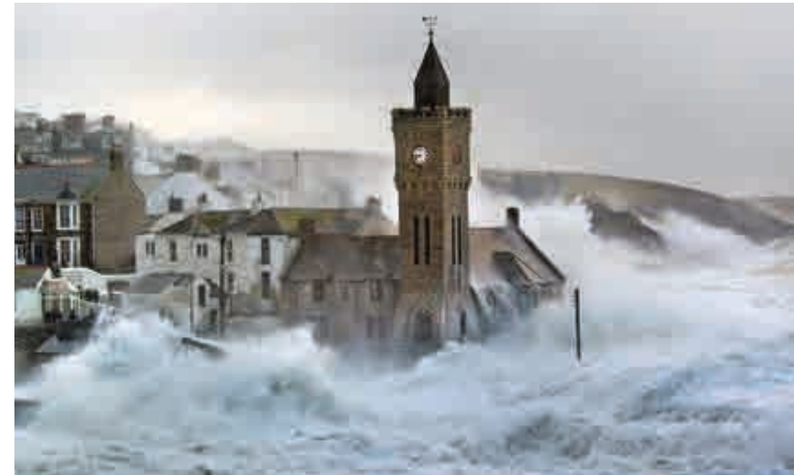
1.22 > Das Dorf Porthleven in der englischen Grafschaft Cornwall liegt an einer besonders energiereichen Felsküste. Entsprechend stark sind die Uferbefestigungen, zu denen massive Mauern gehören. Bei starkem Wellengang allerdings sind diese kaum noch zu sehen.
