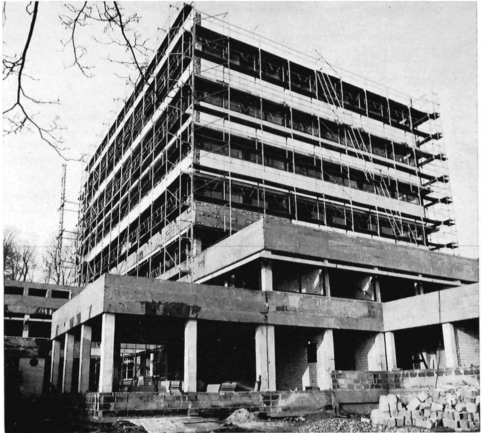
Abb. 2. Ansicht des Institutsneubaues von Südosten, im Vordergrund der Werkstattanbau (Dez. 1970).
